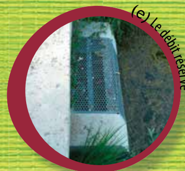
(f) Le déversoir du trop plein
